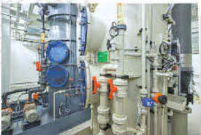
Скрубберы, нейтрализация выбросов Scrubber, exhaust treatment
