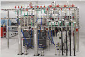
Обвязка технологического оборудования (hook-up) Tool hook-up
